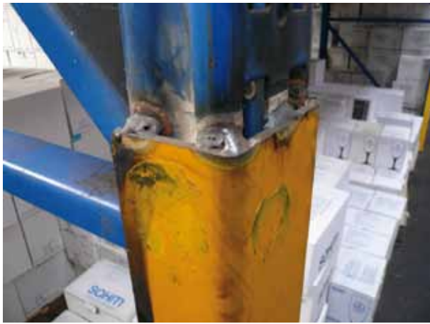
Abb. 11: Unfachmännisch geschweißte Stütze
